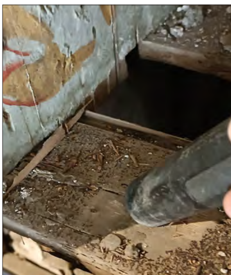
Limpieza mecánica mediante aspiración controlada
