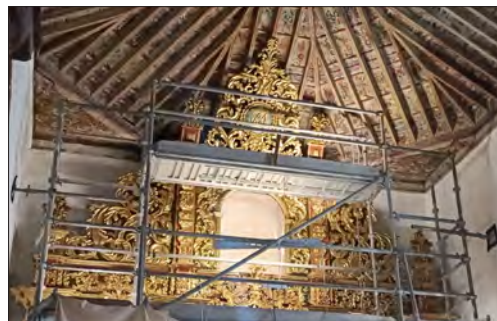
Andamiaje direccional instalado para la intervención restauradora
