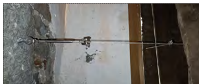
Elementos de refuerzo estructural (montantes, vigas y tensores)
