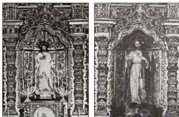
Detalle de la hornacina central con la imagen del Sagrado Corazón tras haberse eliminado la peana de la Virgen y el sol, década de 1930 (izda.). Detalle de la hornacina central con reforma de ampliación en altura con la nueva imagen del Sagrado Corazón, adquirida en 1945 (dcha.)
