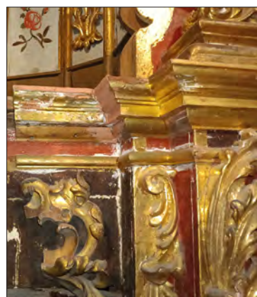
Detalle de daños en la capa de preparación y policroma
