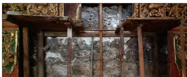
Intervención en la estructura interna del retablo. Retablo de la Virgen de la O
