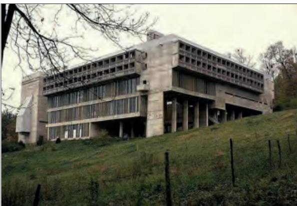
Le Corbusier: convento de Santa María de La Tourette, con las Ventanas Ondulatorias ideadas por Xenakis
