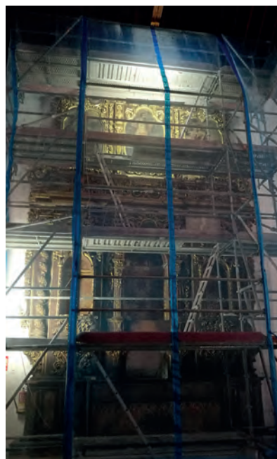
Colocación del andamio direccional
