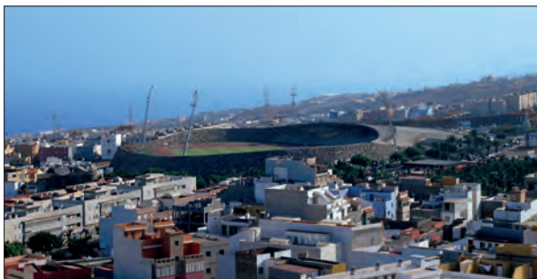
El terraplén del Estadio Insular de Atletismo en Tenerife se realizó con la tierra excavada para la fundación.
