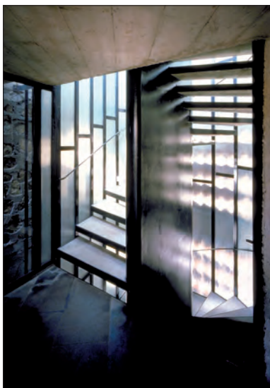
Escalera de la Casa MM, realizada con restos de la refinería desmantelada de Santa Cruz de Tenerife
