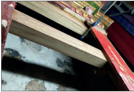
Refuerzos mecánicos. Bastidor interno
