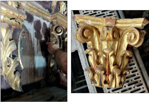
Apeado de elementos que corrían riesgo de desprenderse (izquierda) y detalle del capitel tras ser retirado para su tratamiento (derecha)
