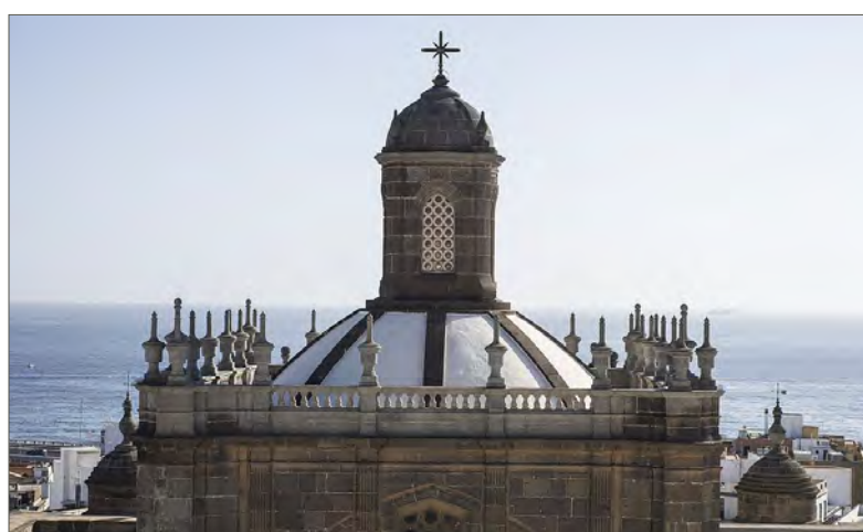
Cimborrio y linterna de la Catedral de Canarias. Las Palmas de Gran Canaria. Restauración realizada por el arquitecto Salvador Fábregas
